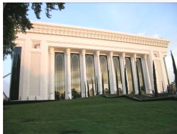
Baustelle Kongresszentrum Taschkent 16.08.2009
