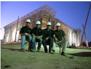
Baustelle Kongresszentrum Taschkent 14.07.2009
